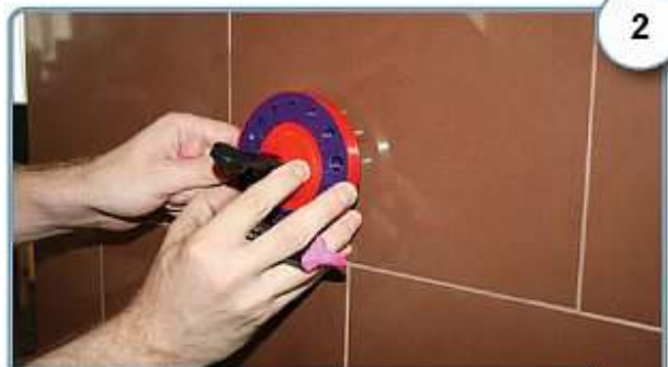
Позиционируйте кондуктор относительно отметки с учетом диаметра коронки.
