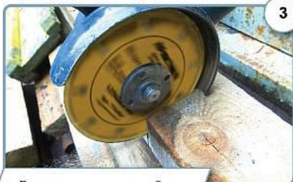
3 Распиливание деревянного бруса
