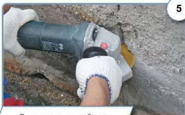
5 Резка армированного бетона
